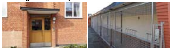
Nya entrédörrar och låsbara cykelförråd
