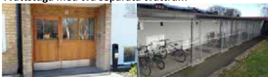
Nya entrédörrar och låsbara cykelförråd
